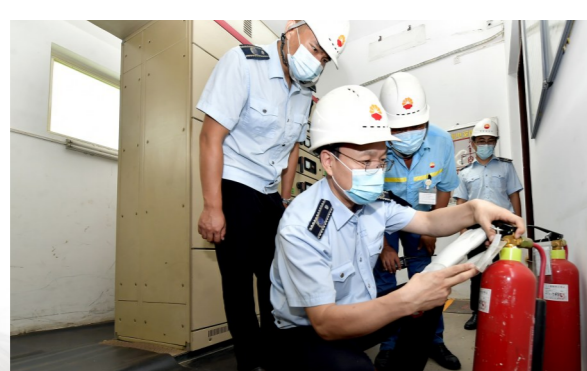
执法人员检查消防设施能否正常使用。
