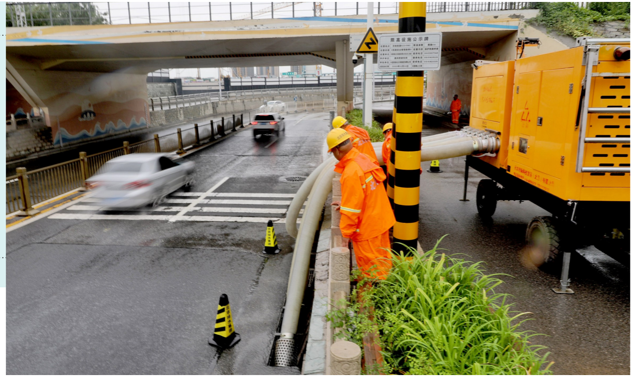
市排水集团工作人员在紫运中路铁道桥下的辅路铺设了六条大口径排水管,以应对大雨排涝工作。记者 白继开/摄
