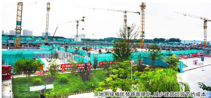
工地用绿植代替路面硬化，减少建筑垃圾节约成本。
