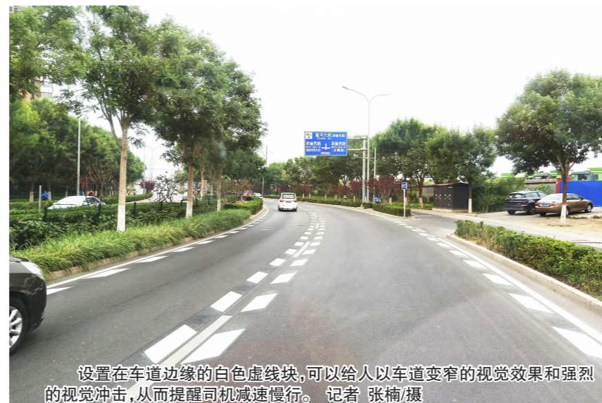
设置在车道边缘的白色虚线块,可以给人以车道变窄的视觉效果和强烈的视觉冲击,从而提醒司机减速慢行。记者 张楠/摄
