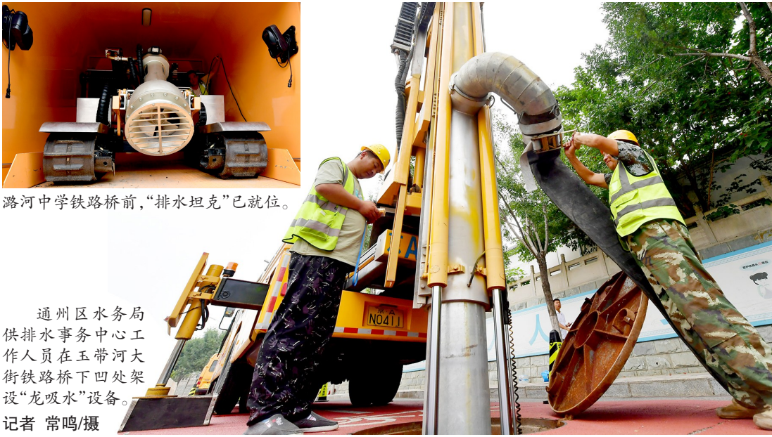
通州区水务局供排水事务中心工作人员在玉带河大街铁路桥下四处架设“龙吸水”设备。
