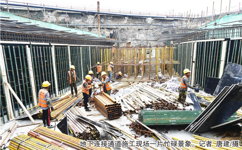
地下连接通道施工现场一片忙碌景象。记者·唐建/摄
