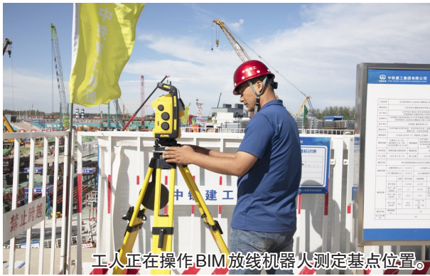
工人正在操作BIM放线机器人测定基点位置。
