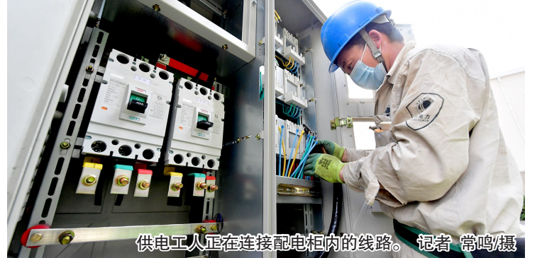
供电工人正在连接配电箱内的线路。 记者 常鸣摄
