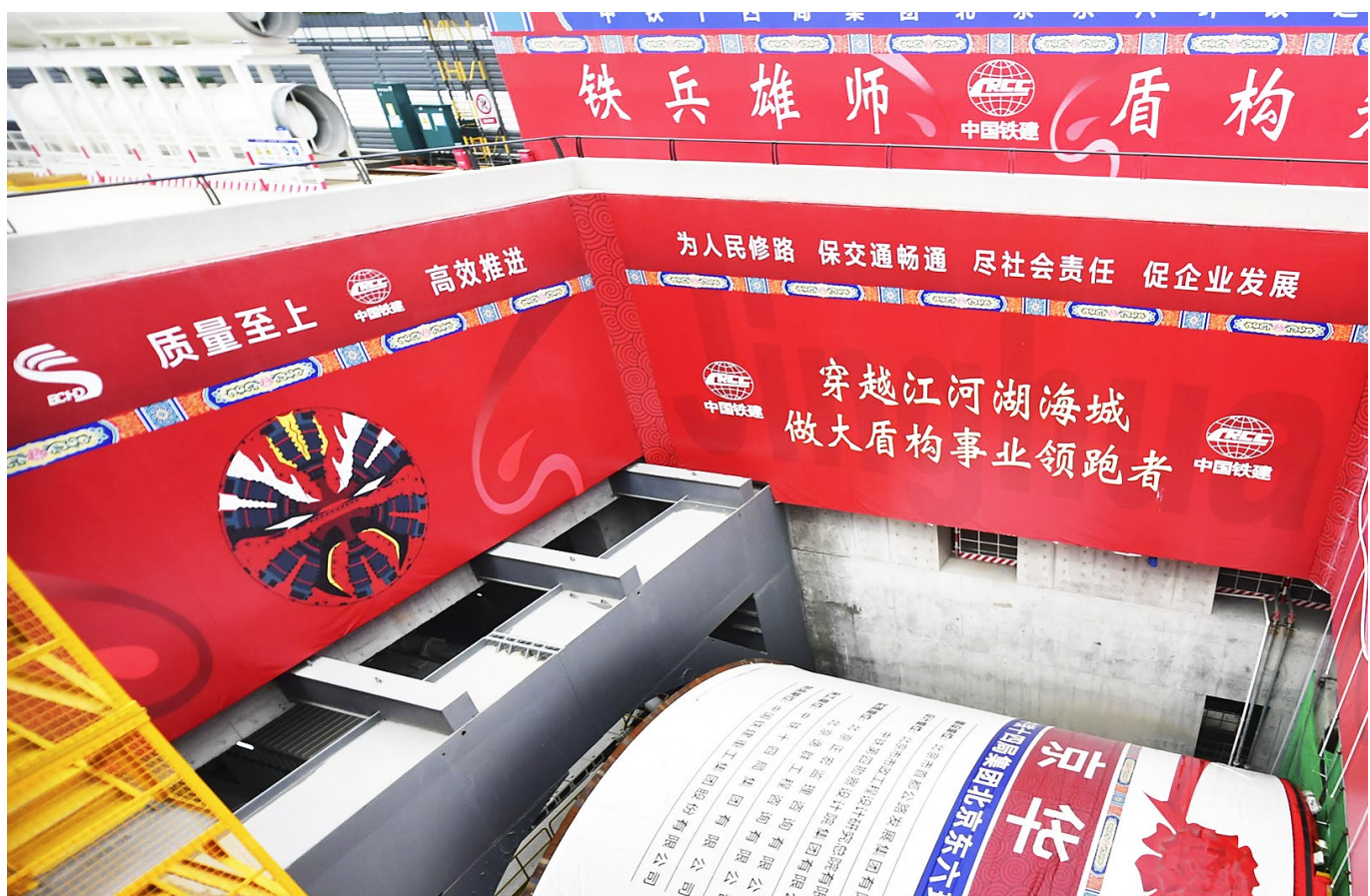
东六环改造工程将启动盾构始发掘进。记者 常鸣/摄
