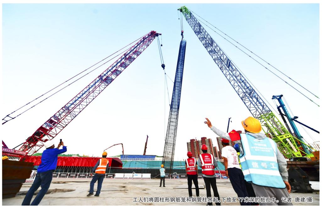
工人们将圆柱形钢筋笼和钢管柱吊起,下放到77米深的桩孔中。记者 唐建/摄
