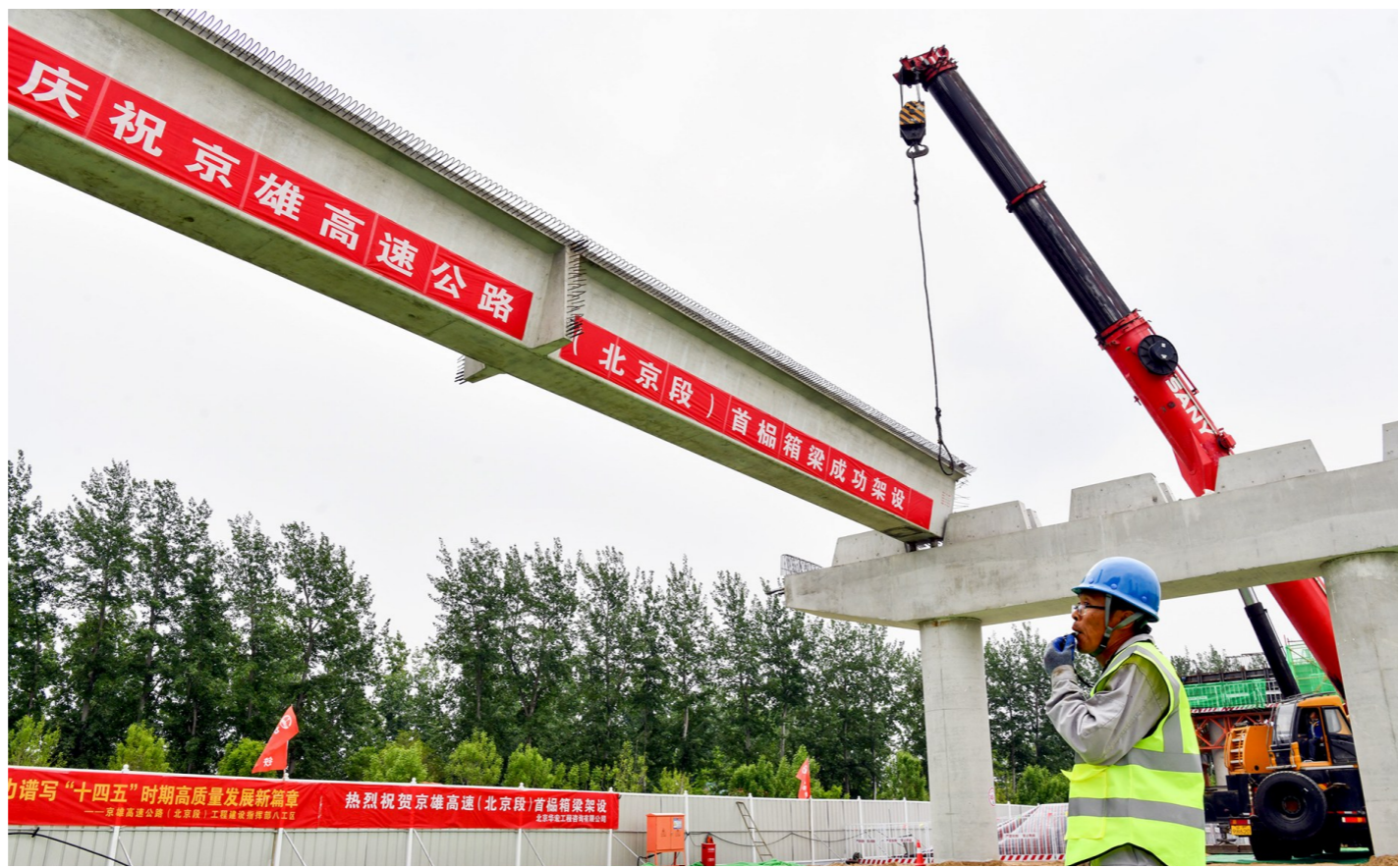
4月25日,京雄高速公路北京段首榀30米箱梁在八工区承建的第三段高架桥正式开始架设,标志着京雄高速北京段工程全面提速。记者 邓伟摄
