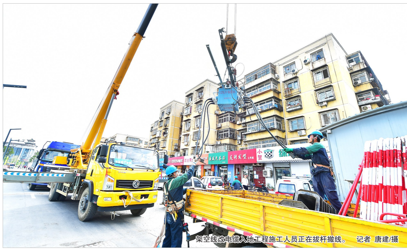
架空线改电缆入地工程施工人员正在拔杆撤线。 记者 唐建/摄
