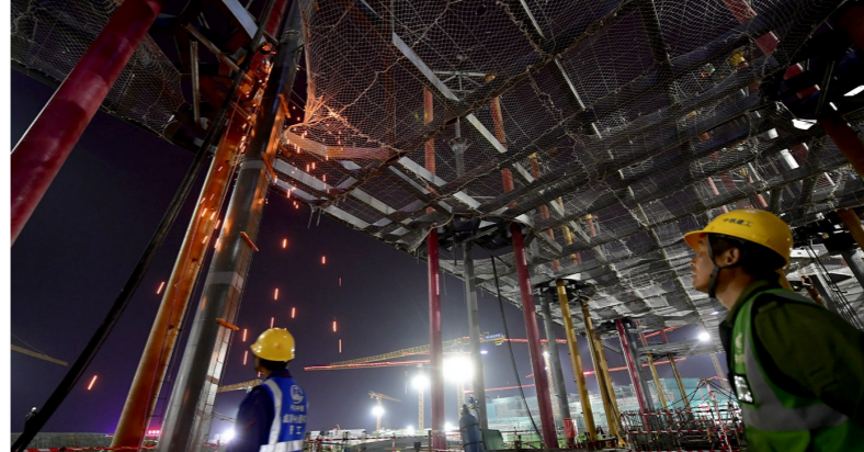
经过加紧焊接，图书馆部分屋盖封顶。
