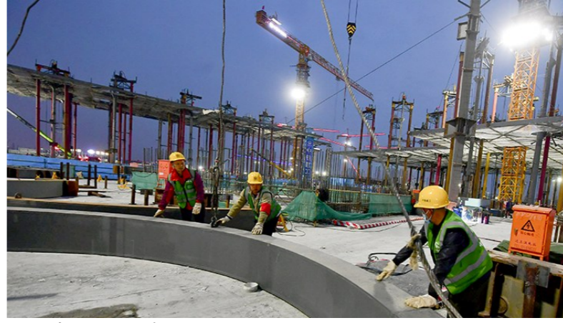
“三大建筑”工地吊装钢结构构件。
