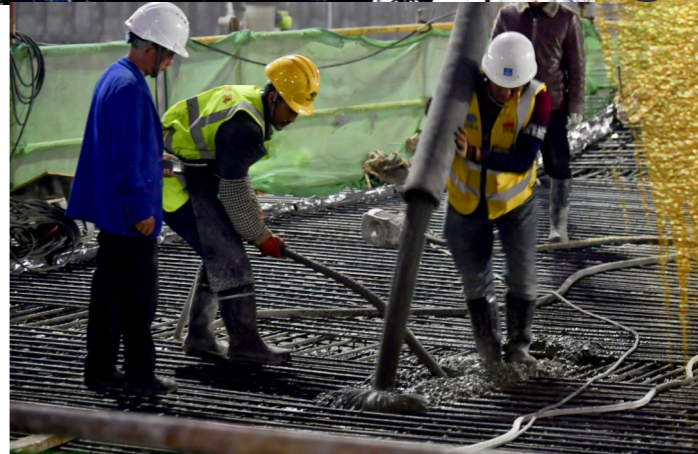
“三大建筑”共享配套设施正在浇筑混凝土。
