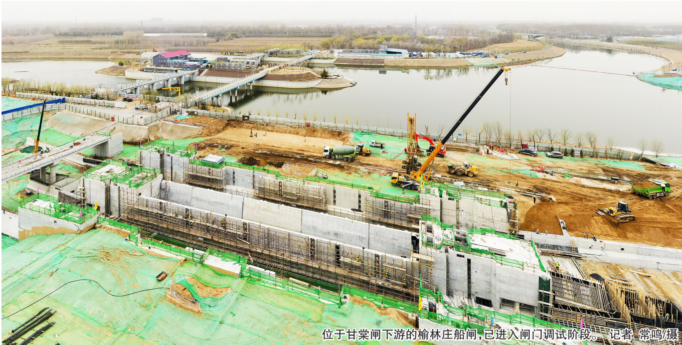
位于甘棠闸下游的榆林庄船闸,已进入闸门调试阶段。记者:常鸣/摄
