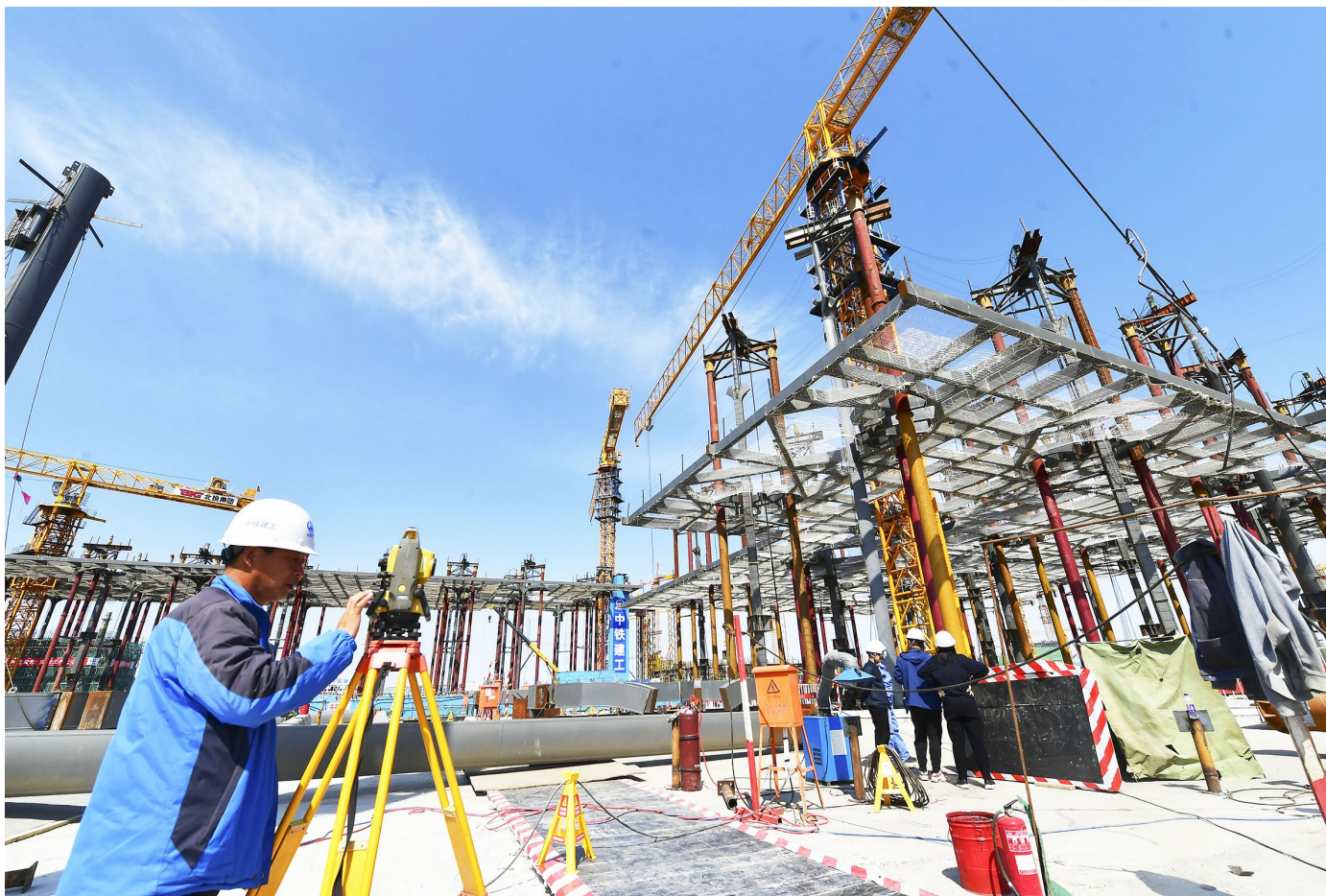
图书馆第二片钢结构屋盖提升到预定点位。 记者 常鸣/摄
