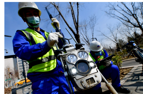
装有远光灯的管道“内窥镜”。
