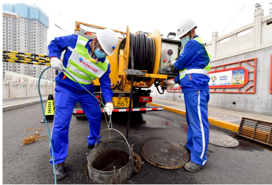
冲井前放下截污装置,防止污物流入管线。
