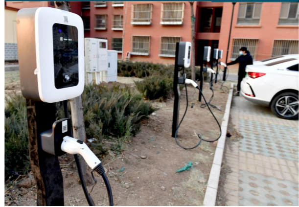
在小区安装充电桩，解决居民充电难题。
