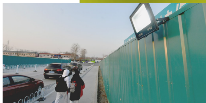
当晚“吹哨”，迅速安装照明设施保障学生安全。
