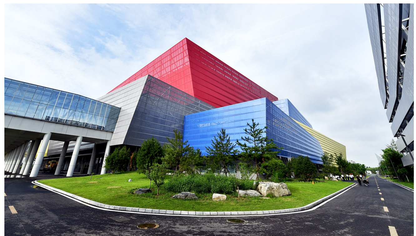
通州循环经济产业园厂房。(资料图) 记者 唐建/摄
