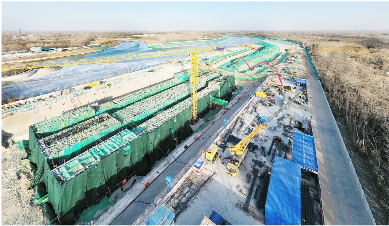
随着天气转暖,榆林庄船闸主体部分覆盖的保温层将被陆续拆除。
