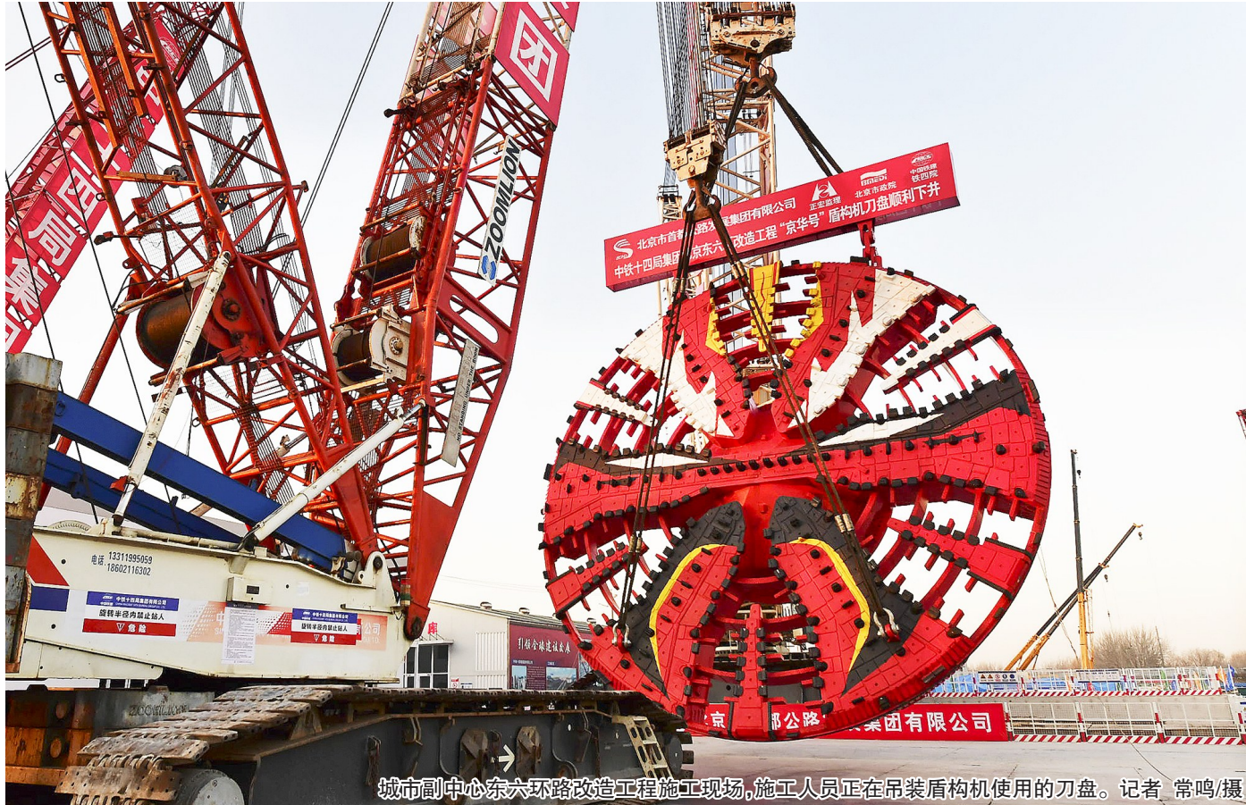
城市副中心东六环路改善工程施工现场,施工人员正在吊装盾构机使用的刀盘。记者 常鸣摄
