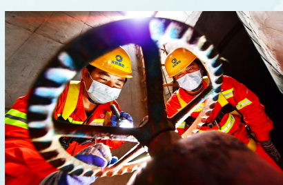
深入地下,保民供热安全平稳的热力检修队。
