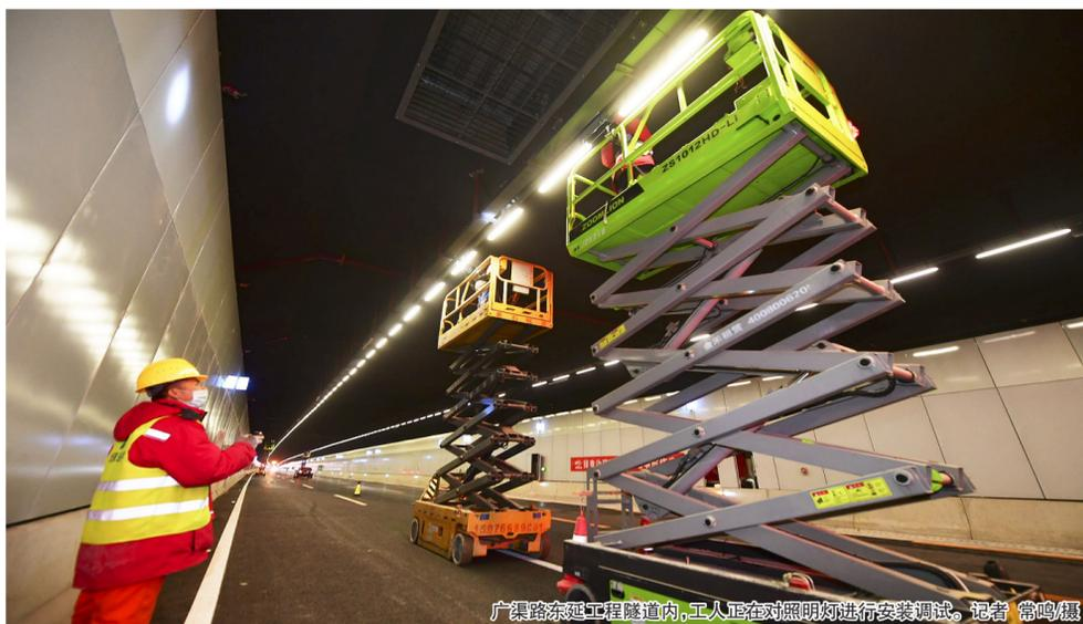
广渠路东延工程隧道内,工人正在对照明灯进行安装调试。记者 常鸣摄
