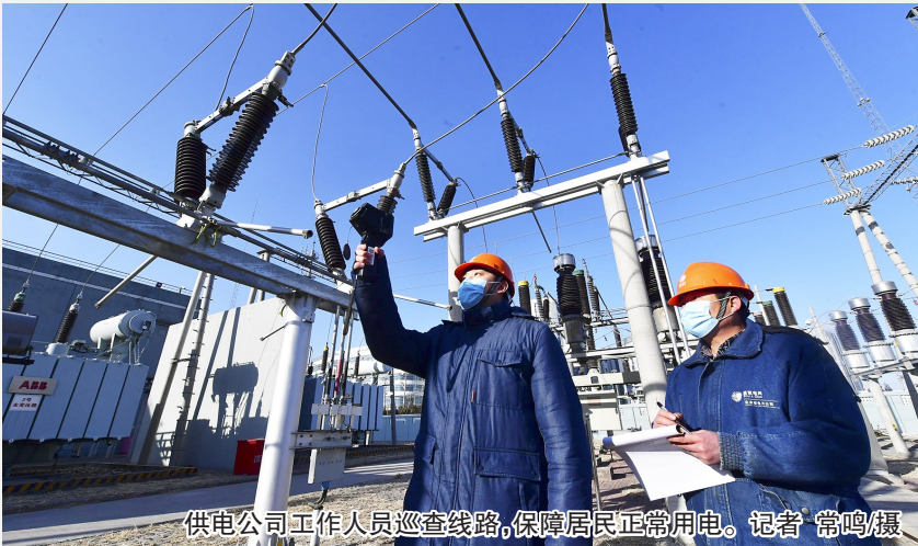
供电公司工作人员巡查线路，保障居民正常用电。记者 常鸣/摄
