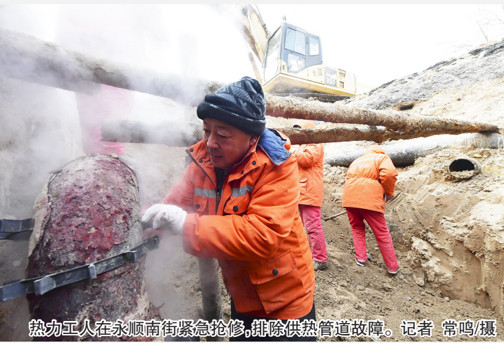
热工工人在永顺南街紧急抢修，排除供热管道故障。记者 常鸣/摄
