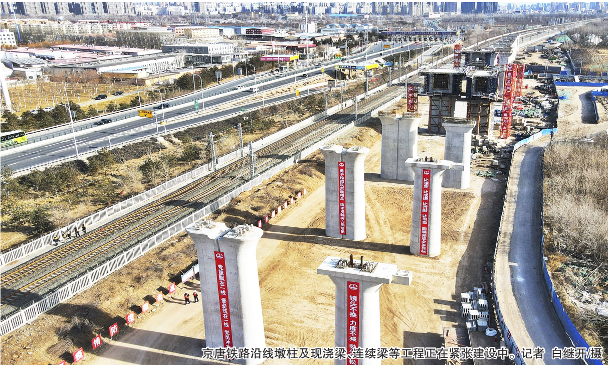
京唐铁路沿线墩柱及现浇梁、连续梁等工程正在紧张建设中。记者 白继开摄
