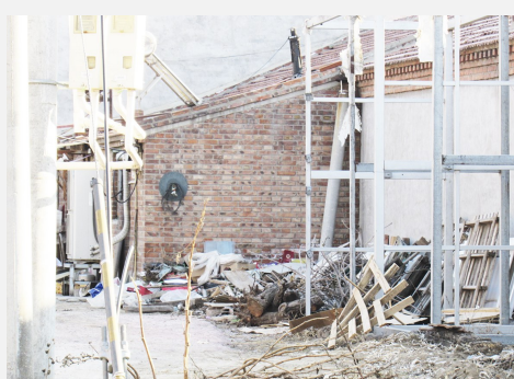
潮县镇龙庄村西北村口南100米东侧路口内堆物堆料
