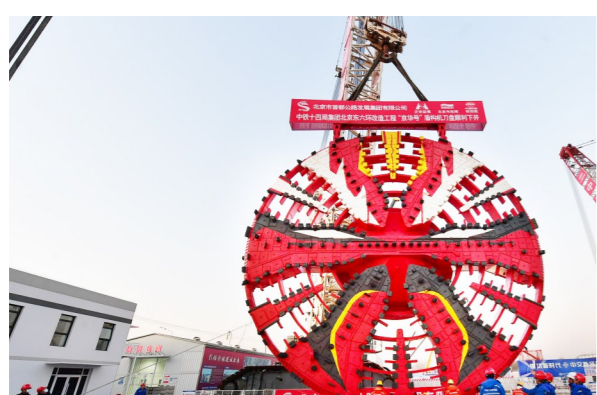
在两台巨无霸级别的履带吊密切配合下,直径16米的荆柯历险刀盘“翻身”准备下井。 记者 常鸣/摄
