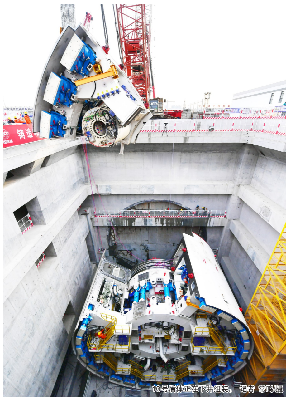
工人正在对刀盘做起吊前的准备工作。
