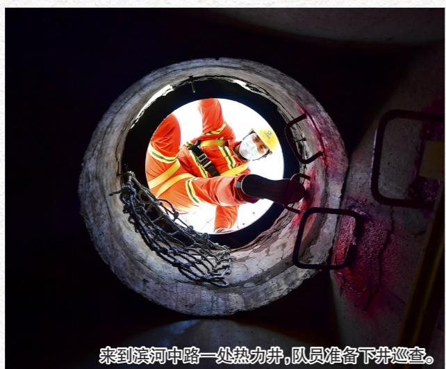
来到滨河中路一处热力井,队员准备下井巡查。
