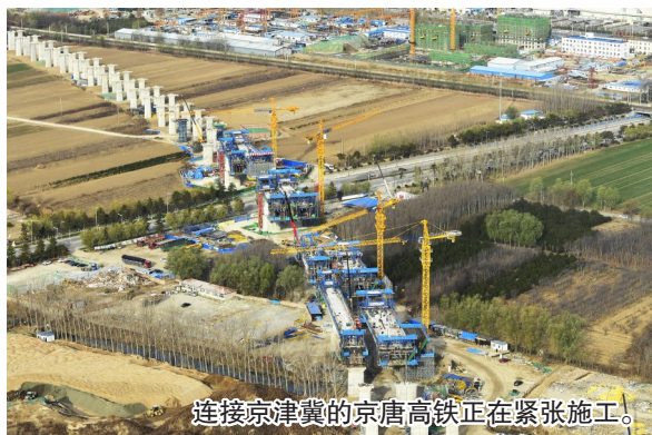
连接京津冀的京唐高铁正在紧张施工。
