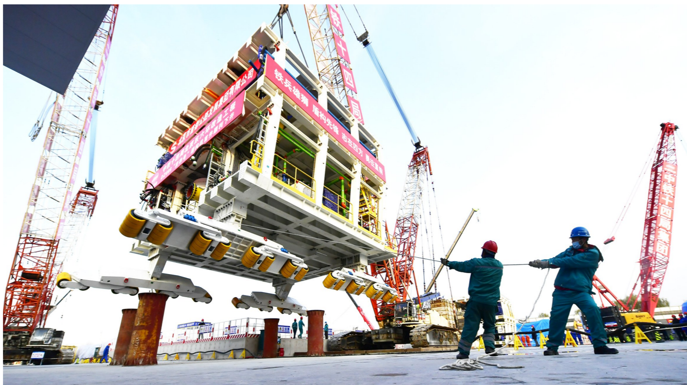
“京华号”1号台车在工作人员的牵引下开始吊装。记者 常鸣/摄
