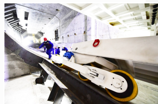
8组黄色的轮组平稳地降落在基坑轨道上。
