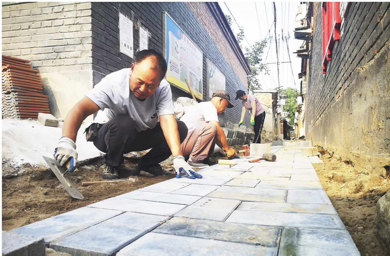
在小微项目资金支持下,中仓街道白将军社区200多米长的排水管道及路面全部换新,方便居民生活。(资料图) 记者 党维婷摄
