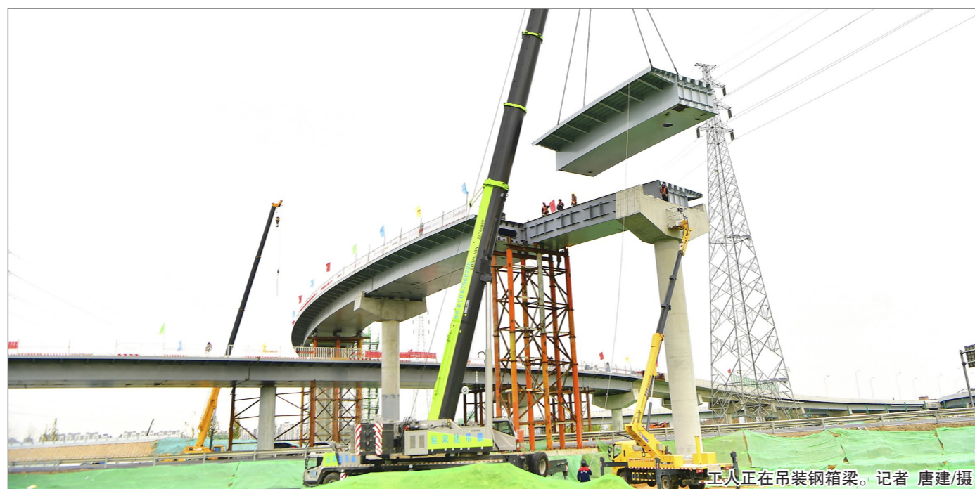
工人正在吊装钢箱梁。记者 唐建/摄
