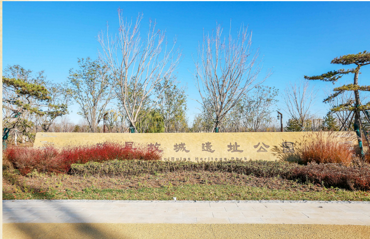
路县故城遗址公园先行启动区已完成工程面积约26公顷。
