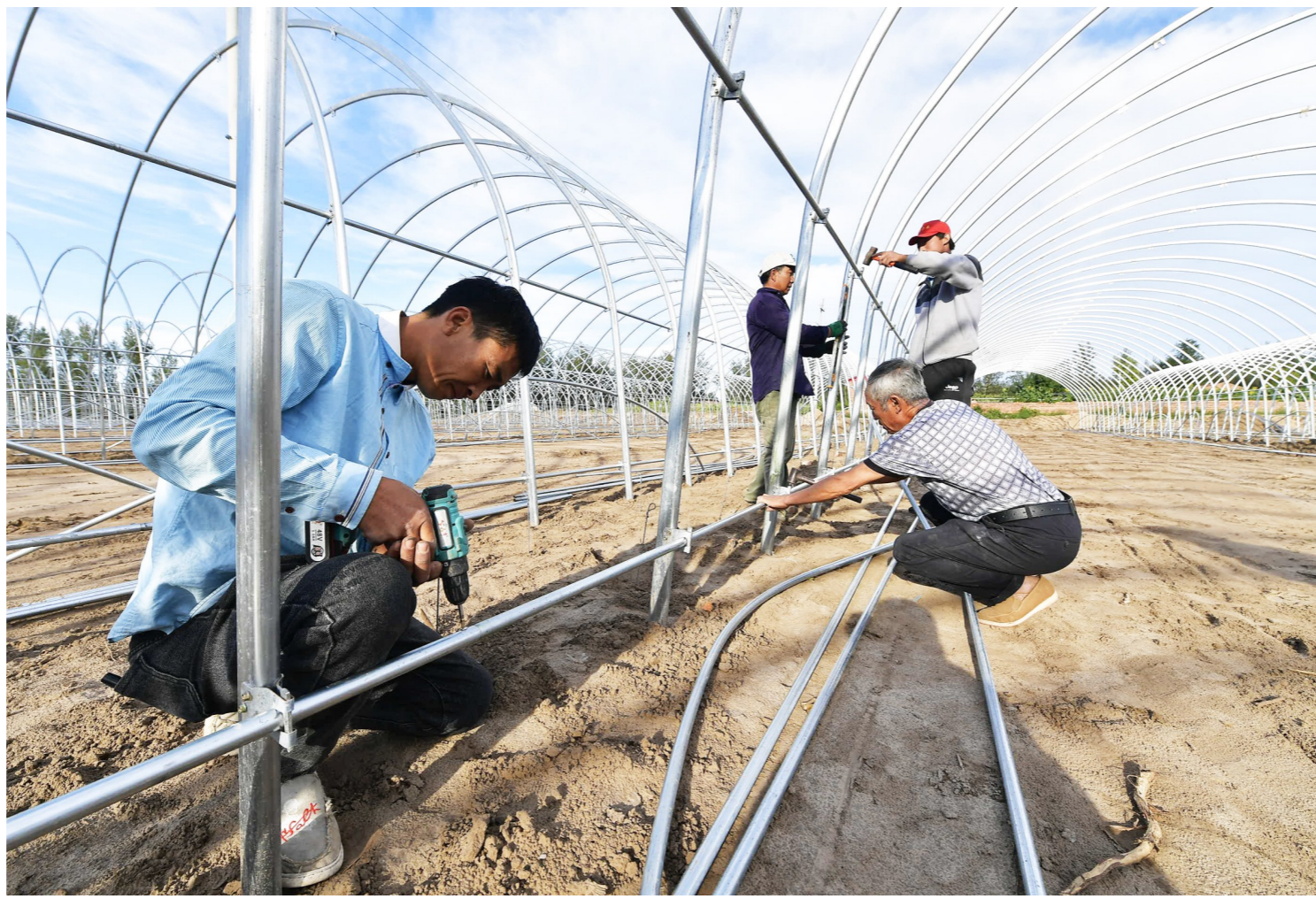
通州区出资为内蒙古通辽市奈曼旗义隆镇援建的大棚正在施工。(资料照片)记者 常鸣/摄
