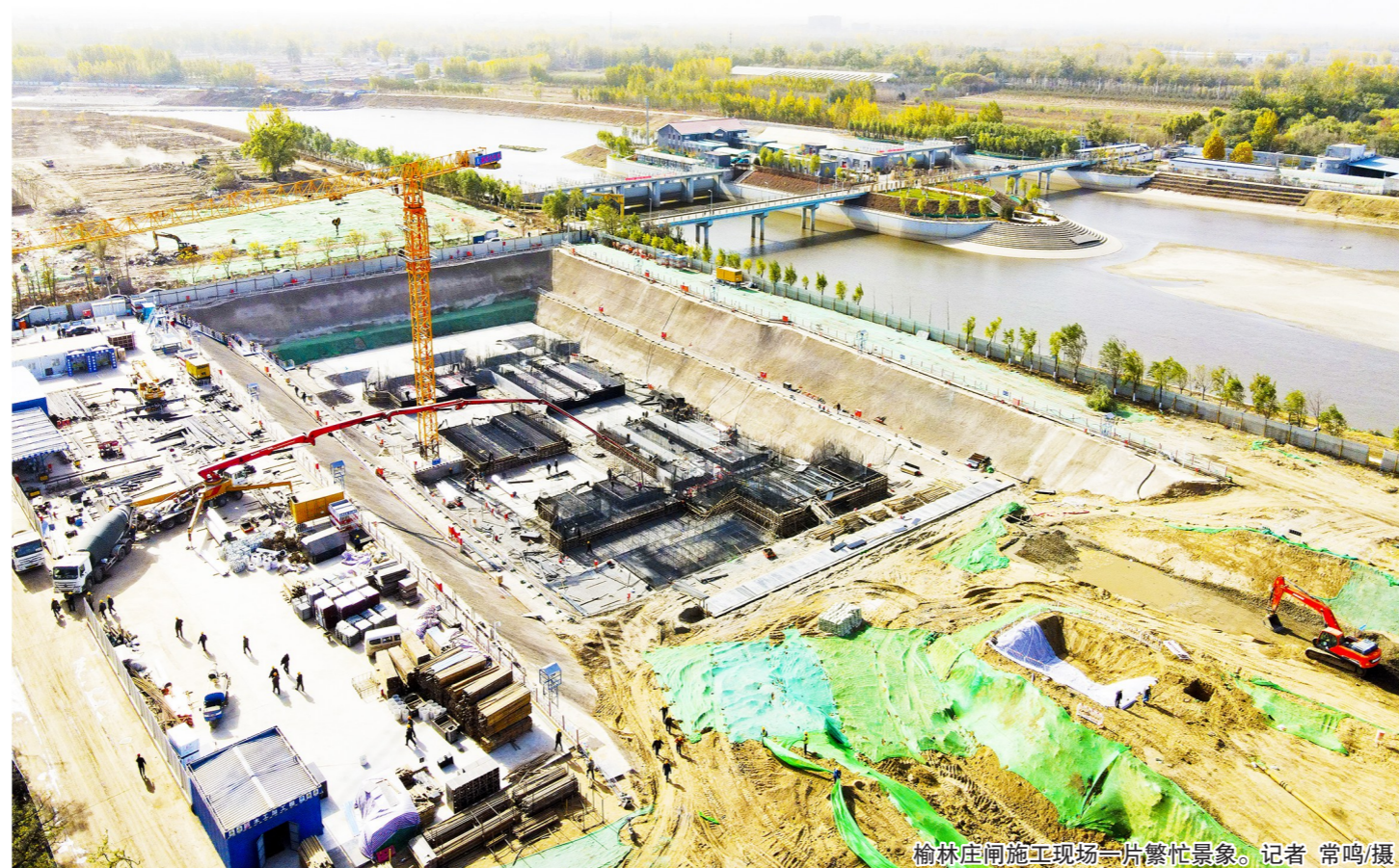
榆林庄闸施工现场一片繁忙景象。记者 常鸣/摄
