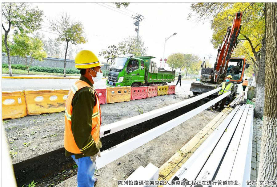
陈列馆路通信架空线入地整治工程正在进行管道铺设。 记者 常鸣/摄
