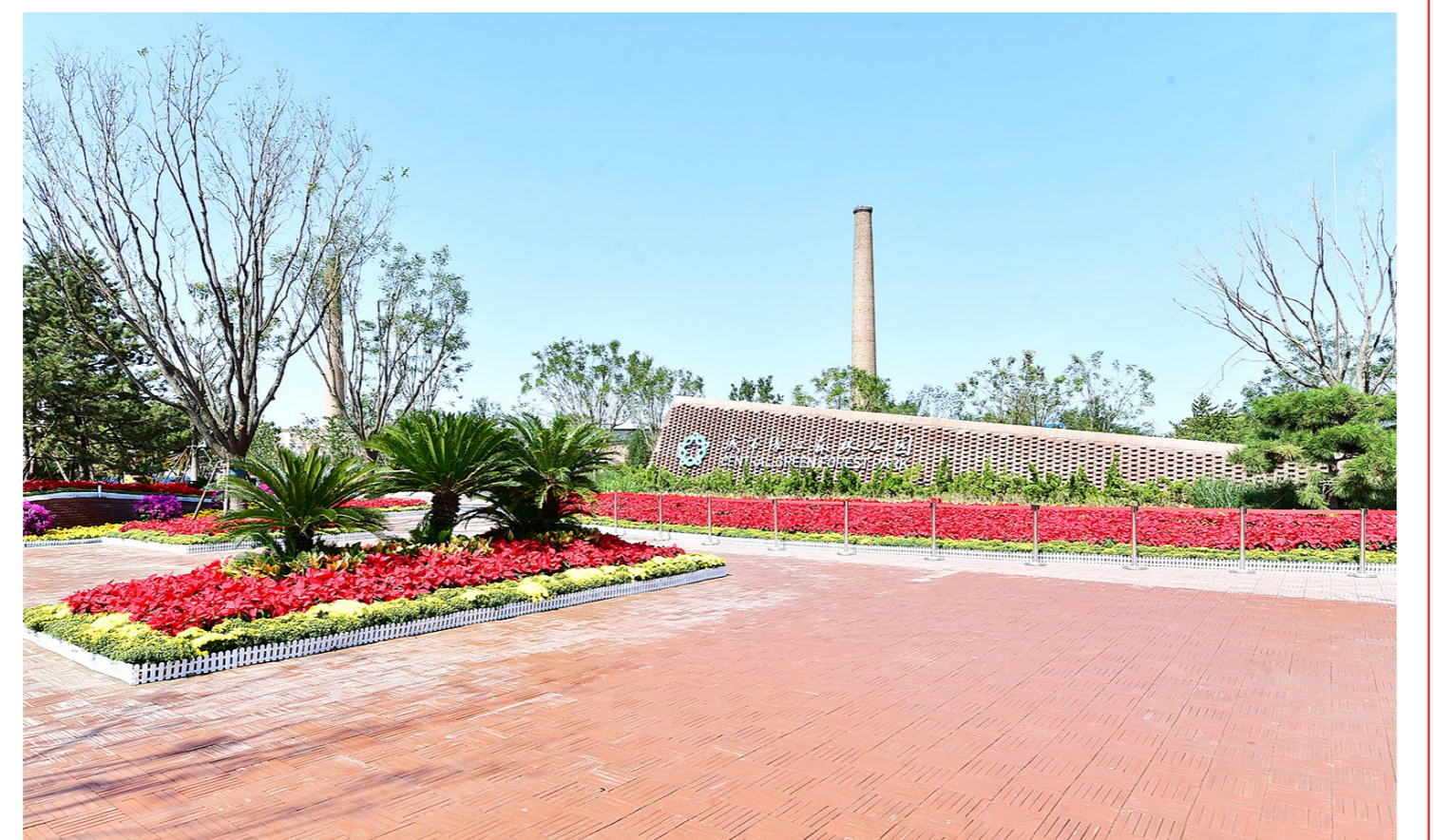
作为工厂记忆的标志性建筑,大烟囱矗立在红砖广场上。 记者 唐建耀
