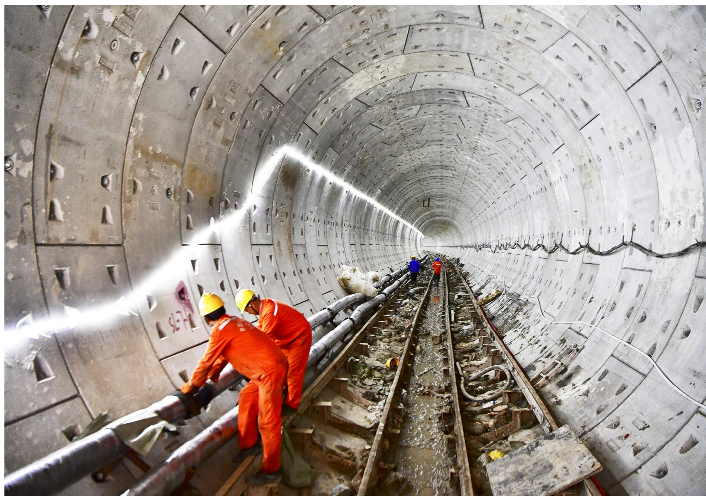
该区间隧道正式贯通,工作人员正在准备下一步施工所需设备。记者 唐建/摄
