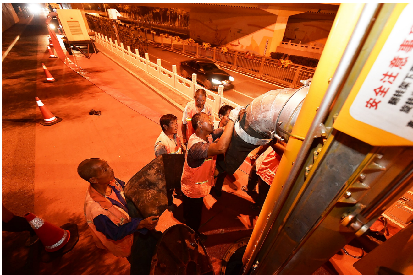
8月11日21时,区供排水事务中心工人正在玉带路东大街京哈铁路涵洞桥下安装排水设施。 记者 常鸣/摄
