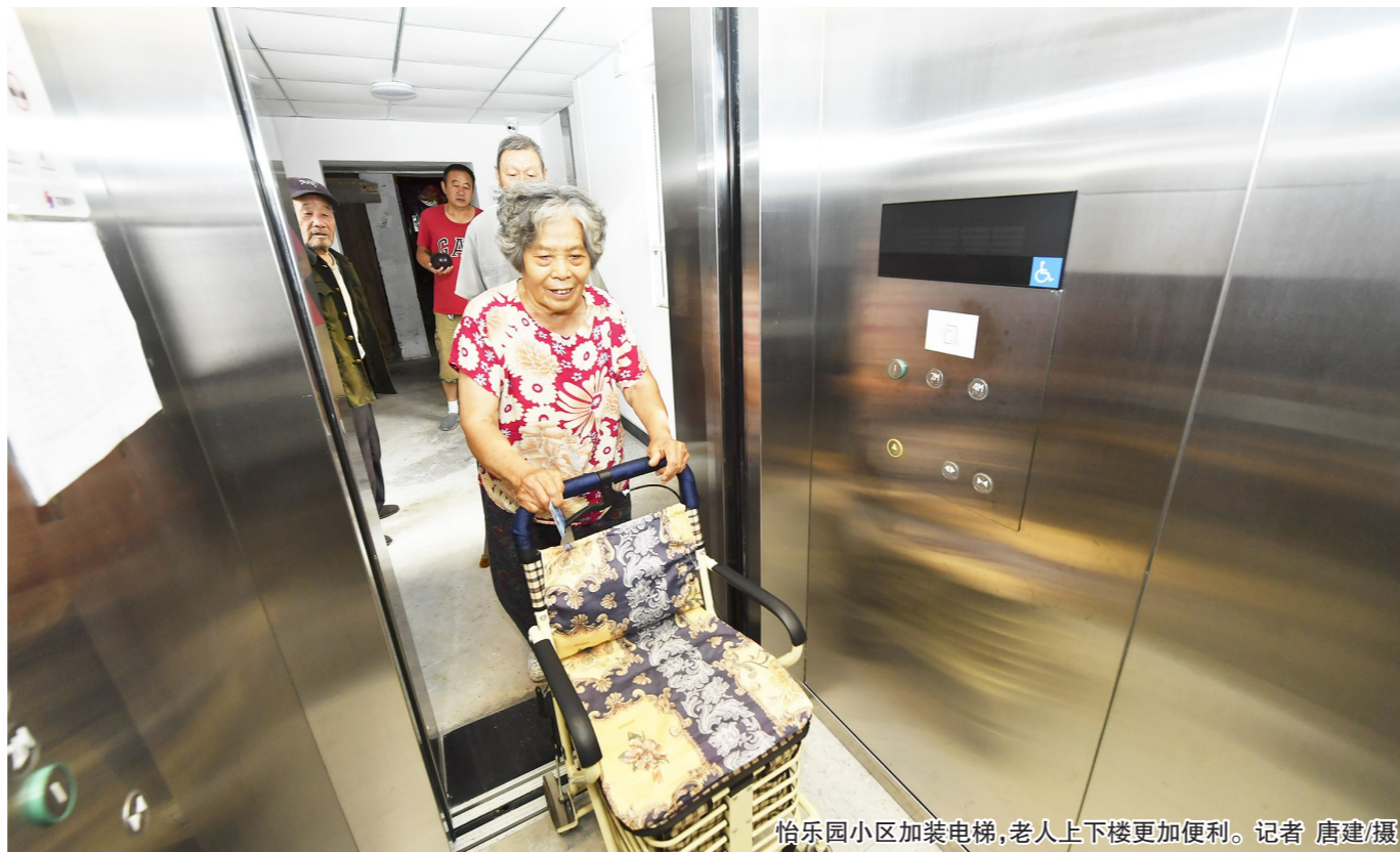
怡乐园小区加装电梯,老人上下楼更加便利。记者 唐建/摄
