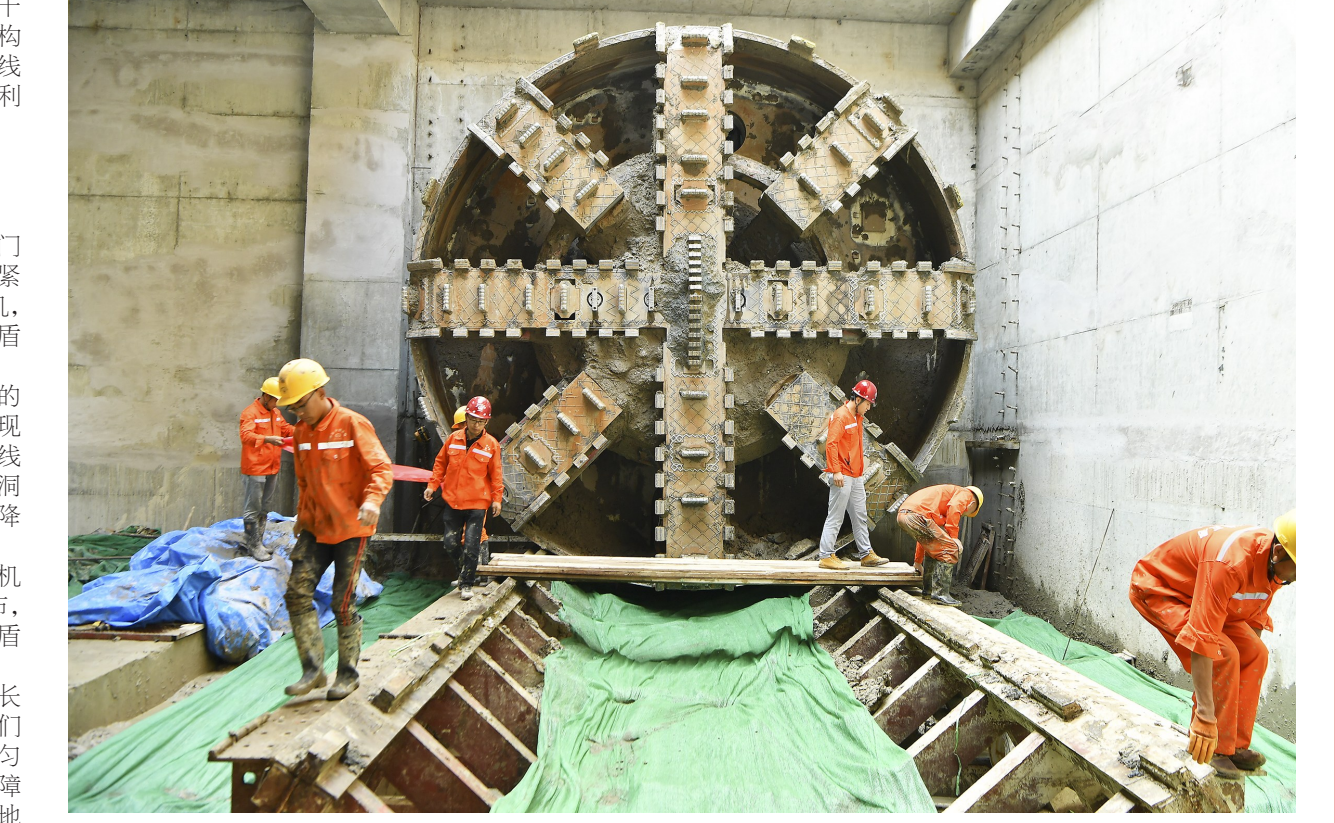
随着机器的运行,覆土深度约11至18米的隧道安全贯通。记者 唐建/摄
