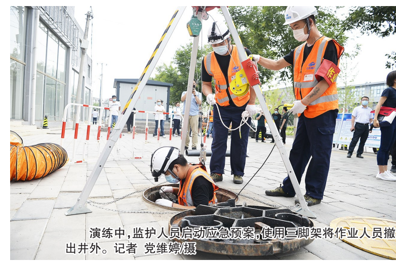
演练中,监护人员启动应急预案,使用三脚架将作业人员撤出井外。记者 董维娟摄
