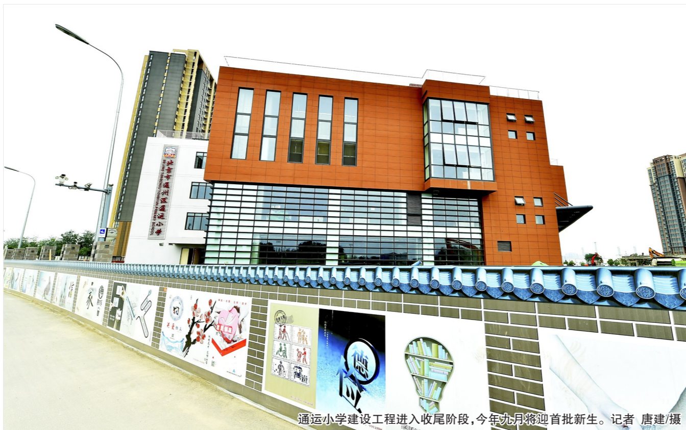
通运小学建设工程进入收尾阶段，今年九月将迎首批新生。记者 唐建/摄
