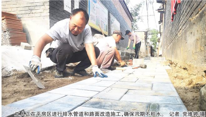
工人正在平房区进行排水管道和路面改造施工,确保汛期不积水。 记者 董维娟/摄
