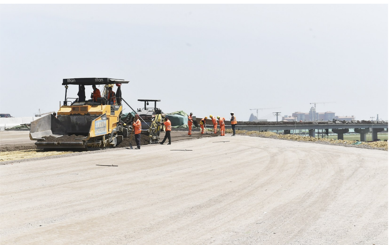
工人正在对文化旅游区连接京哈高速的匝道桥路面进行施工。 记者 常鸣/摄
