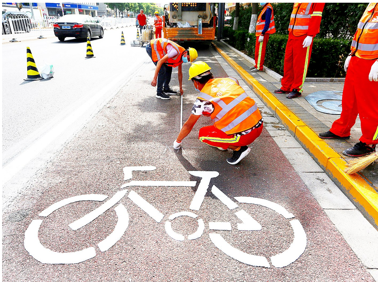
工人们加紧施工,力争月底实现自行车图标和导向箭头“应标尽标”。 记者 唐建斌
