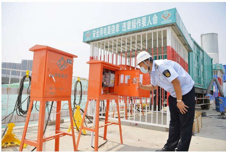
在广渠路东延项目施工现场，安全监察员检查高空作业、特种车辆、变配电箱等安全情况。
